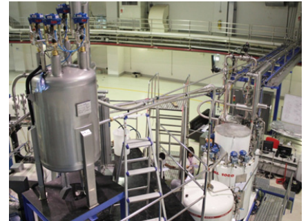
รูปที่ 2 อุปกรณ์หลักของระบบผลิตฮีเลียมเหลวของสถาบันฯ ได้แก่ Cold Box และ Main Dewar
