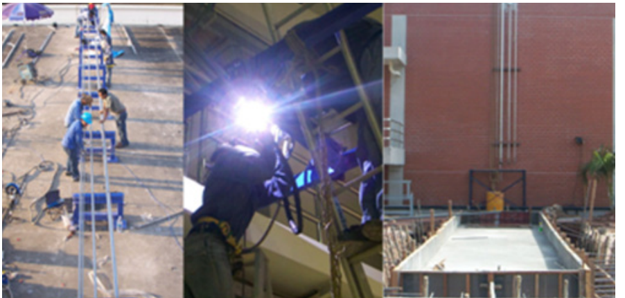
รูปที่ 3 สถาบันฯ ได้ดำเนินการออกแบบและติดตั้งระบบท่อส่งก๊าซฮีเลียม
