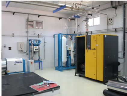
รูปที่ 1 อุปกรณ์หลักของระบบผลิตฮีเลียมเหลวของ สถาบันฯ ได้แก่ Main Compressor, Recovery Compressor, Oil Removal System และ Gas Dryer
